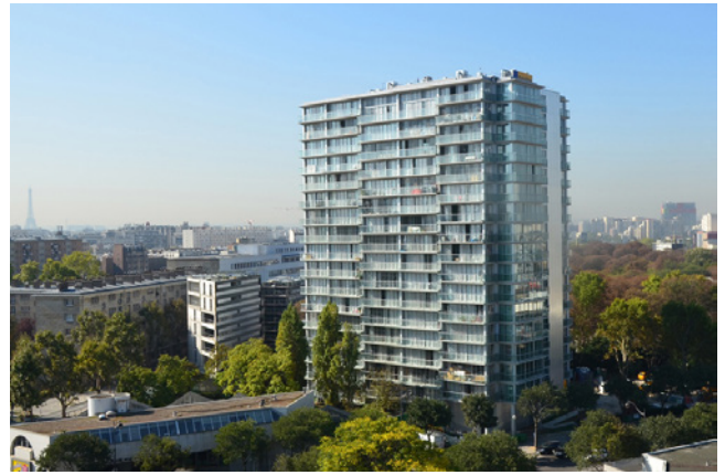
Tour Bois le Prêtre (Bron: Lacaton & Vassal)
