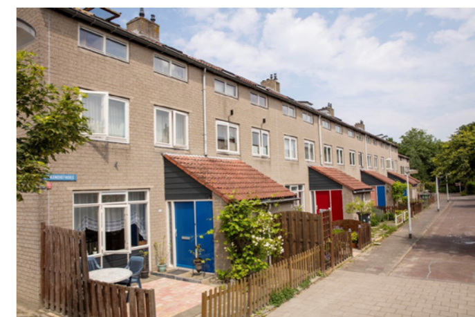
Kiekendiefhoek Source: Housing Corporation De Leeuw van Putten
