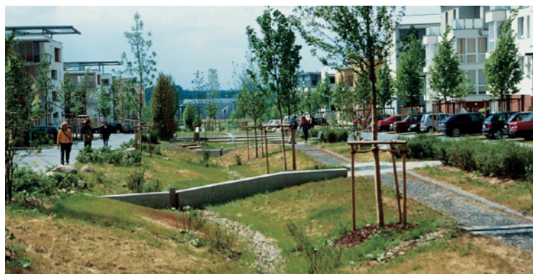
Een wadi voorkomt uitdroging van de grond, overbelasting van het riool en tegelijk vormt het een natuurlijke omgeving voor planten en dieren. (Rotterdamsweerwoord.nl)
