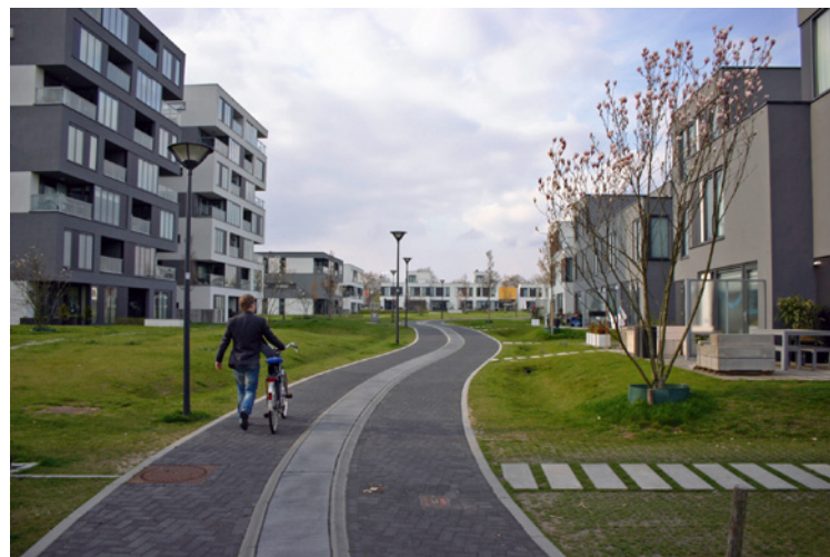
Straat waarin de huizen alleen ontsloten worden door voet- en fietspaden (Frijthof Nijmegen, Buro Lubbers)
