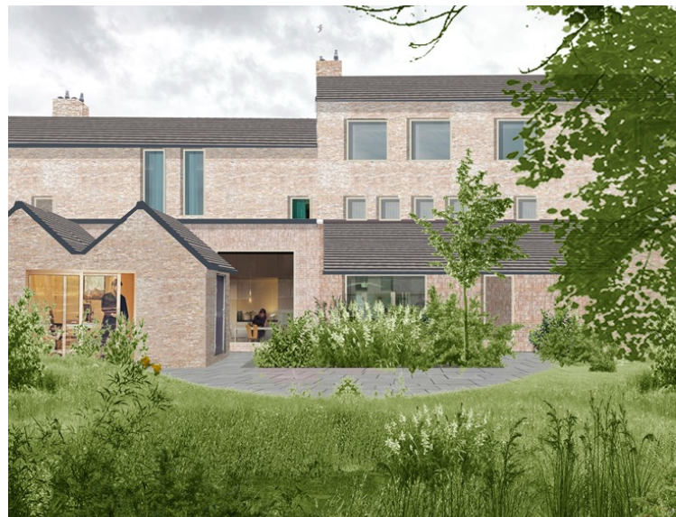
Facelift van woningen De Hoek 1 door isolatie als onderdeel van de energietransitie. De gevels zijn voorzien van een tweede huid van keramische steentrips met isolatie. Dubbel glas in nieuwe kozijnen, schuurtjes omgebouwd tot werkruimte en groene herinrichting van de straat.
