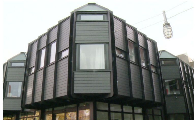
Renovatie van De Roef, het eerste gebouw van Almere Haven dat in 1976 werd geopend als café, restaurant, buurtcentrum en kerk. Tegenwoordig in gebruik als appartementen en fysiopraktijk. (lalmere.nl)
