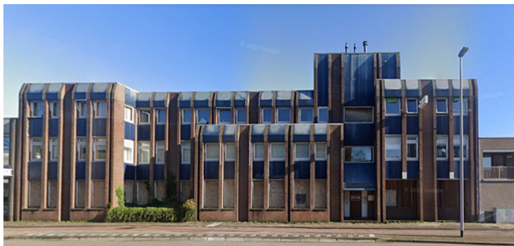
Kantoren uit de jaren zeventig in Purmerend aan de centrale Waterlandlaan staan op de nominatie voor afbraak (Google maps)
