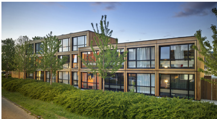
Tijdelijke, modulaire houten woningen met een gevel van circulaire panelen, Alkmaar, 2020 (Finch Buildings)
