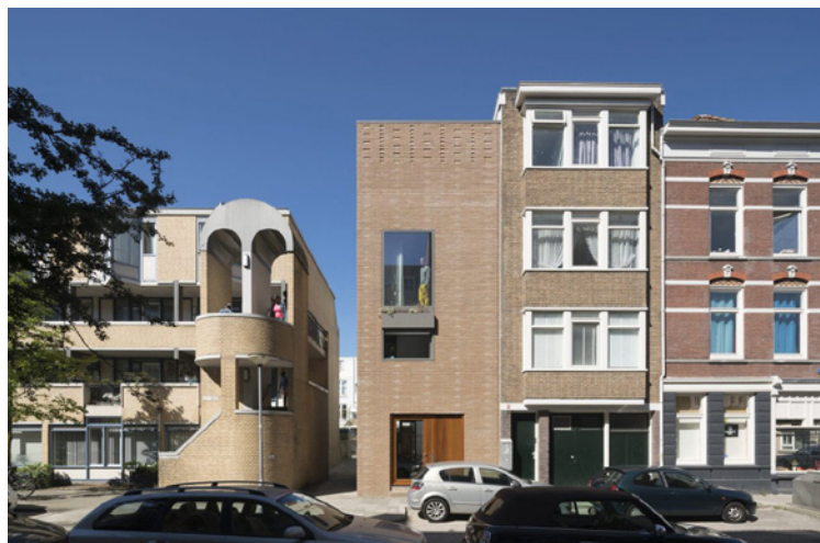
Inbreiding aan de Gouvernestraat in Rotterdam, met een gevel van bakstenen, gemaakt uit bouwafval (architectuurMAKEN)
