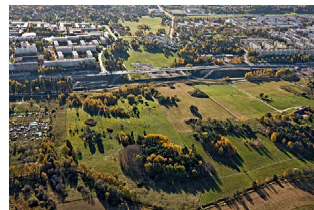
Viaduct in Tensta bij Stockholm, Swedish National Heritage Board, 2010 (commons.wikimedia.org)
