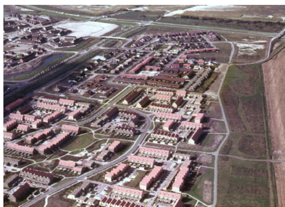
Luchtfoto van de Karveel en de Boeier richting het westen, met op de voorgrond het buurtje van bureau Zanstra, De Clercq, Zubli, Lammertsma en Partners en daarachter aan de stadsrand het rijtje woningen van de Stichting Houtskeletbouw Lelystad, 1979 (Het Flevolands Archief, Rijksdienst voor de IJsselmeerpolders, Potuyt)
