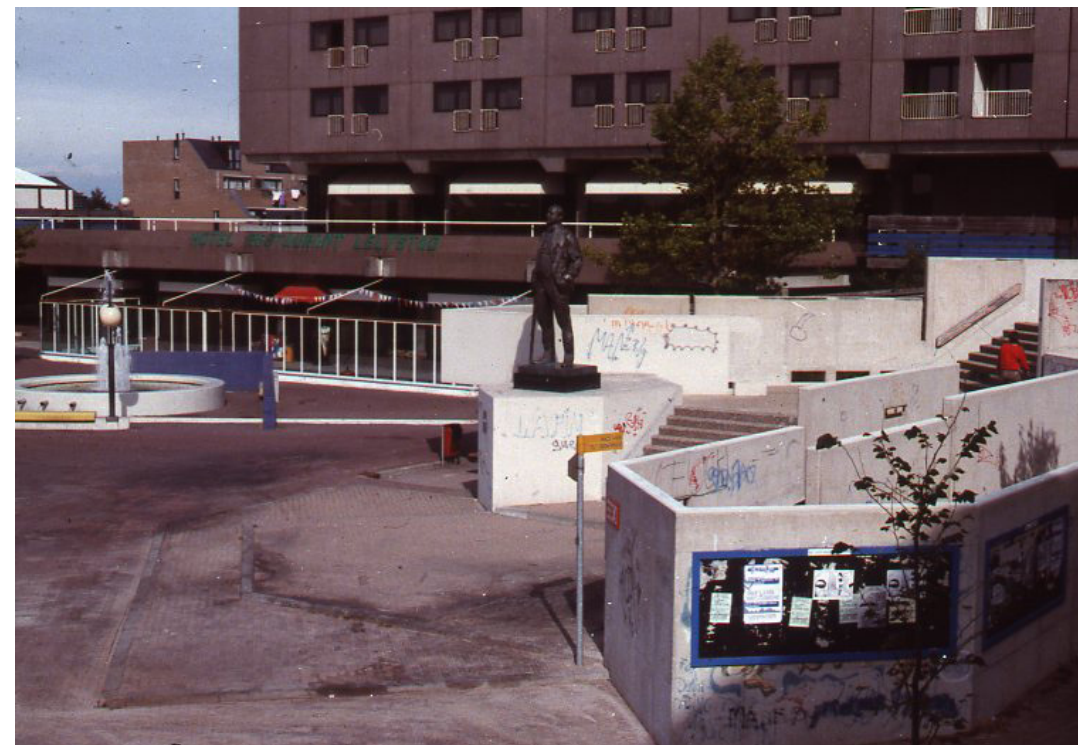
Agorahof met betonnen trappen en verhoogde passages, al vroeg na de oplevering stenig, verwaarloosd en unheimisch, 1986 (Het Flevolands Archief, Rijksdienst voor de IJsselmeerpolders, Potuyt)
