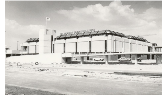
Supermarkt en winkelcentrum De Boer, 1976 (Het Flevolands Archief, Rijksdienst voor de IJsselmeerpolders, Potuyt). In 1978 is het gebouw afgebrand.
