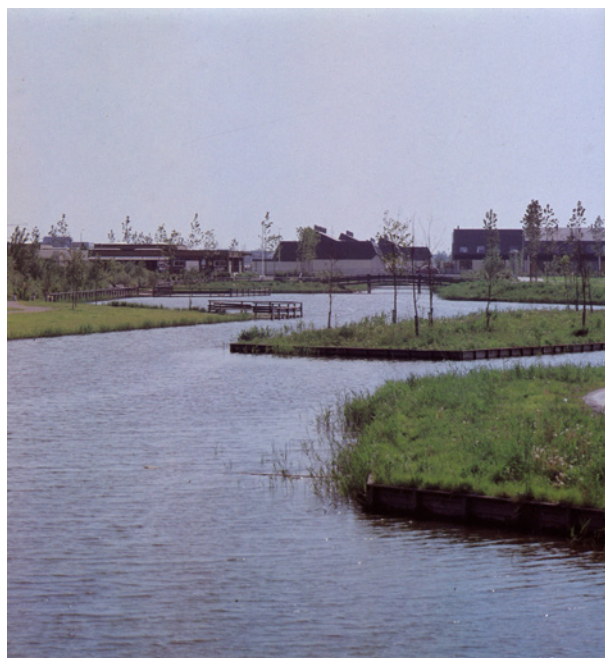
Het vijverpark tussen de Schouw en de Kempenaar, 1979 (Lelystad Compleet Anders)
