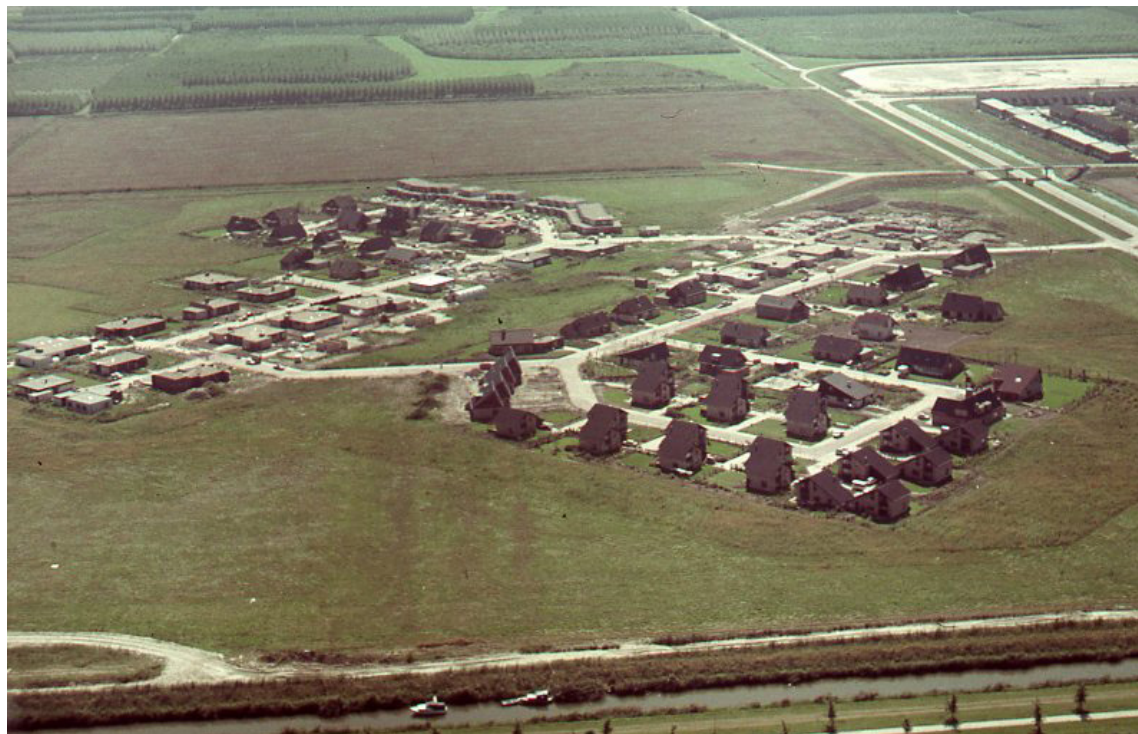
Oostrandpark in aanbouw, 1975 (Het Flevolands Archief, Rijksdienst voor de IJsselmeerpolders, Potuyt)
