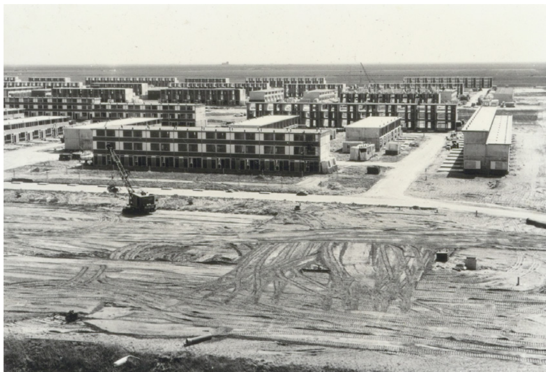
Bouw van Vaneg-systeembouwwoningen in de eerste zuidelijke woonbuurt, 1970 (Het Flevolands Archief, Rijksdienst voor de IJsselmeerpolders, Potuyt)
