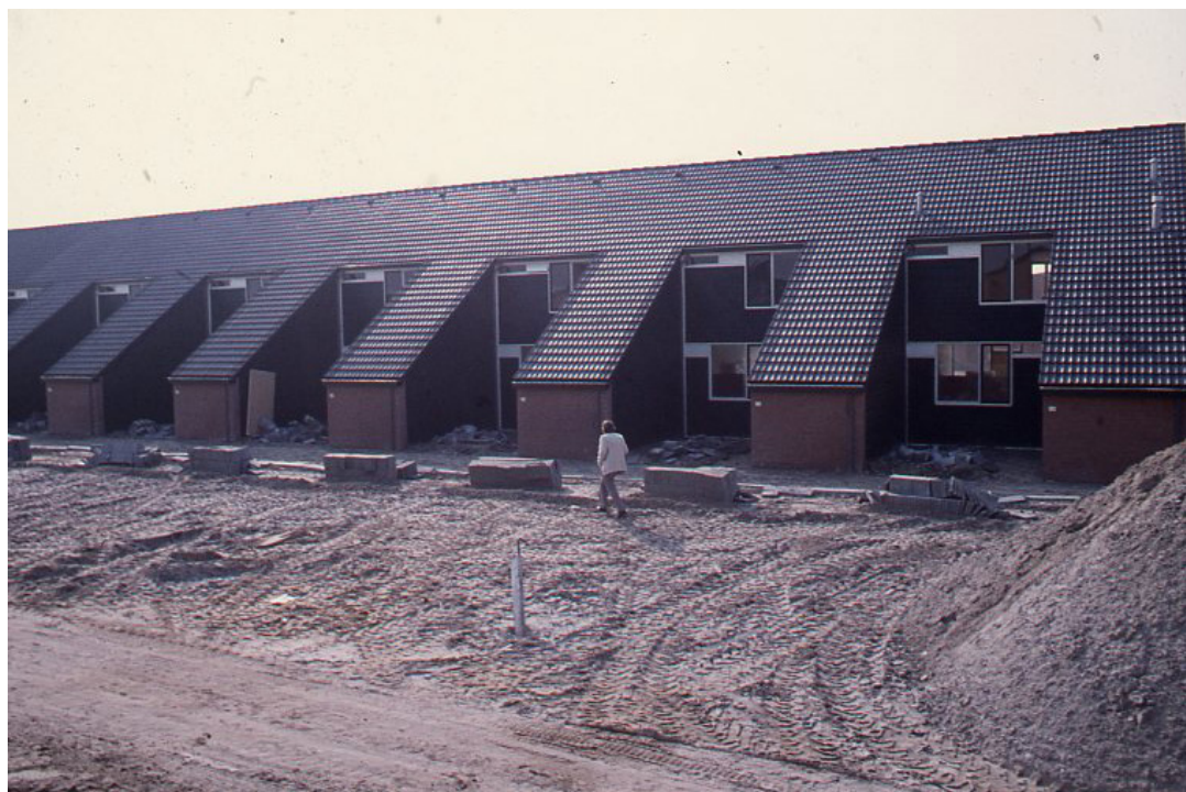
Woningen in de Plantage waarvan een dakvlak tot over de berging is doorgetrokken, 1974 (Het Flevolands Archief, Rijksdienst voor de IJsselmeerpolders, Potuyt)
