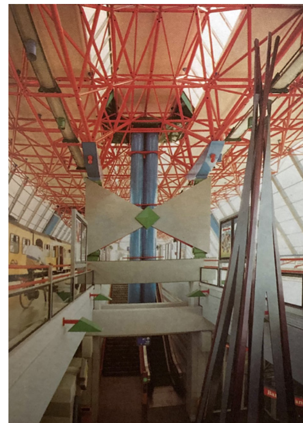
Rood ruimtevakwerk, gedragen door vlinderdas-vormige kolommen, 1989 (BOUW, nr. 13, 19-06-1989)
