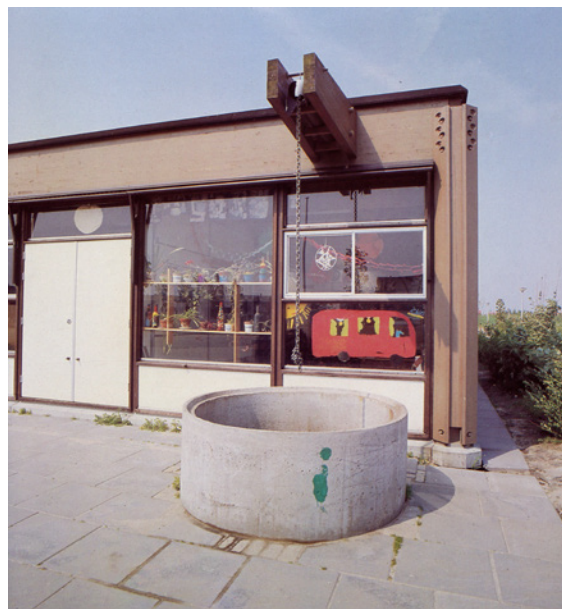
Regenwaterafvoer die veel is toegepast bij de openbare kleuter- en lagere scholen, 1979 (Lelystad Compleet Anders)
