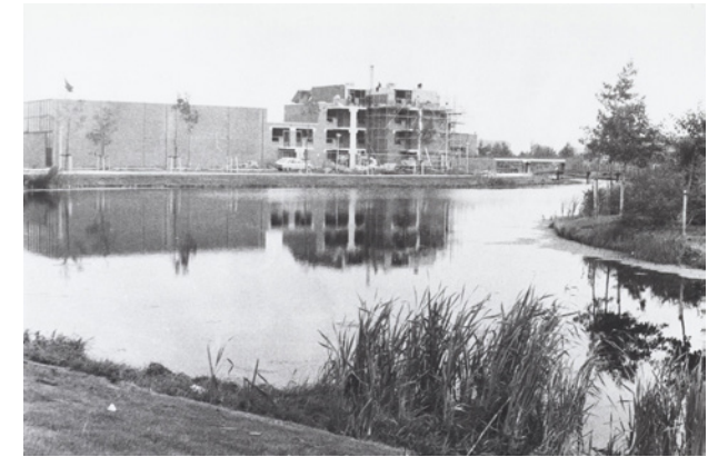
Achterzijde van het complex in aanbouw, 1980 (Collectie Waterlands Archief)
