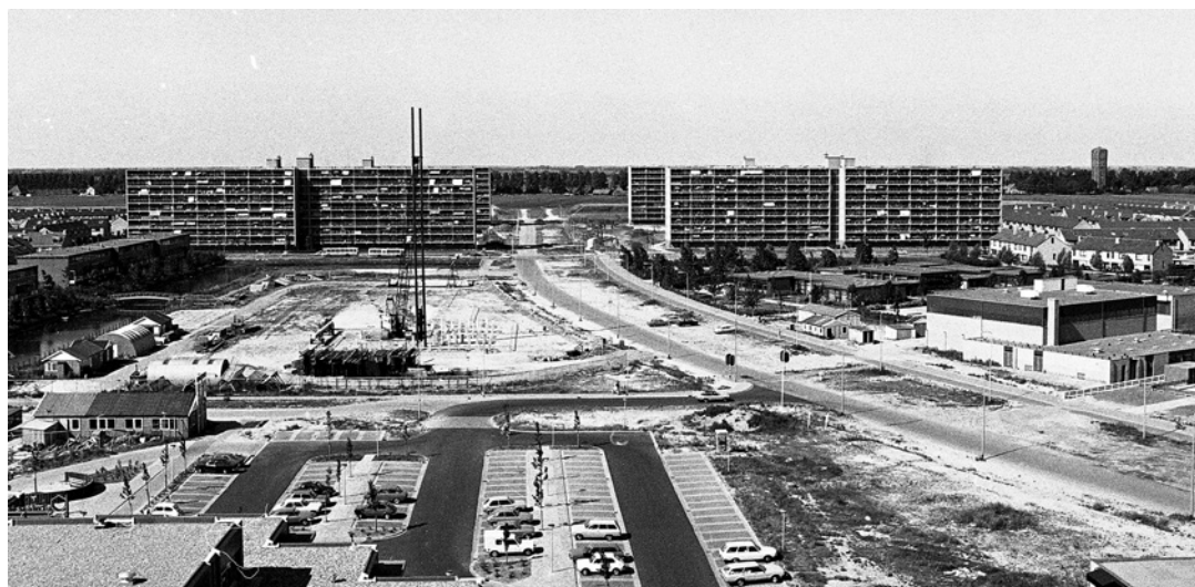
Overwhere-noord in aanbouw, gezien vanuit het zuiden, met in het midden de brede Salvador Allendelaan, 1976 (Waterlands Archief)
