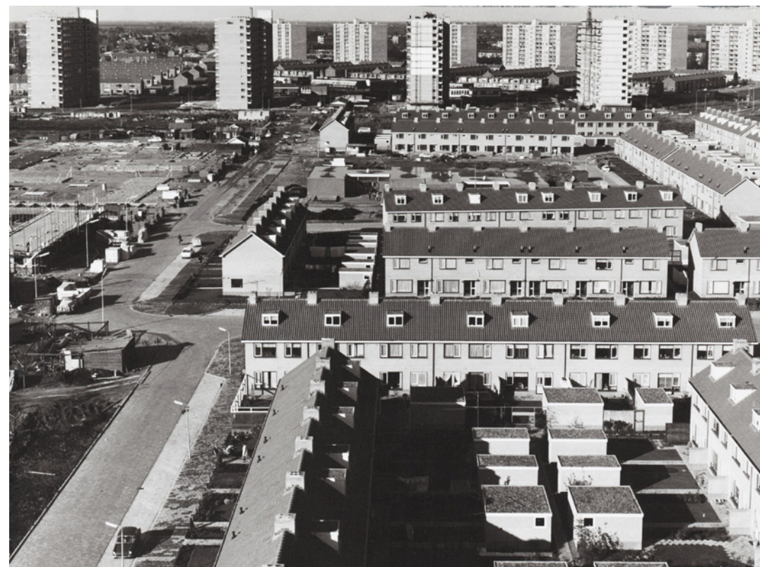
Wheermolen-oost met op de achtergrond de hoogbouw van Wheermolen-west langs de Churchillaan en verderop langs de spoorlijn, 1970 (Beeldbank Waterlands Archief)
