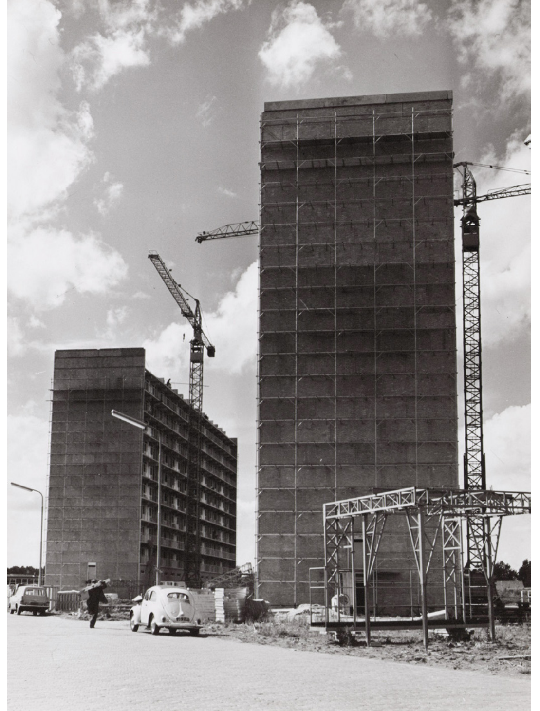
Galerijflats in aanbouw aan de noordwestelijke rand van Wheermolen, 1967 (Beeldbank Waterlands Archief)
