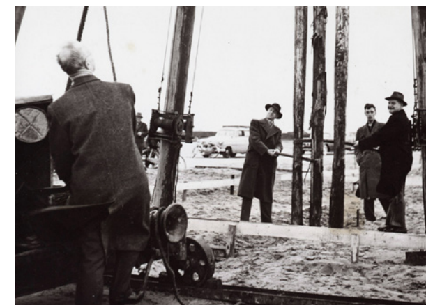
Burgemeester Kooiman slaat de eerste heipalen in Overwhere, 1957 (Beeldbank Waterlands Archief)
