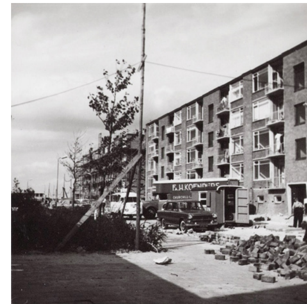
Portieketageflats aan de Maasstraat in aanbouw, 1961 (Beeldbank Waterlands Archief)
