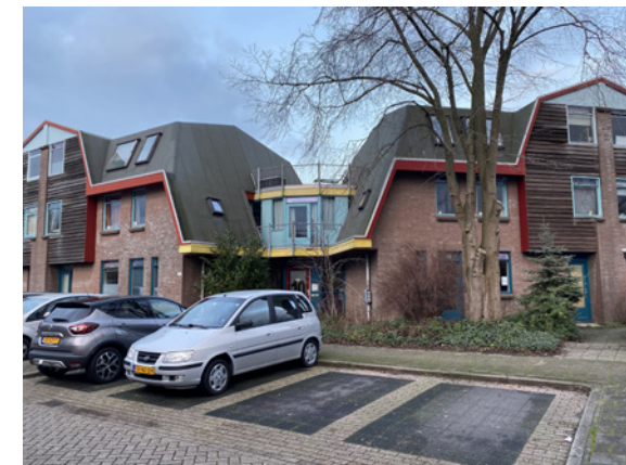
Een van de entrees van het Centraal Wonen complex aan de Lisdoddestraat, De Gors-noord, 2021
