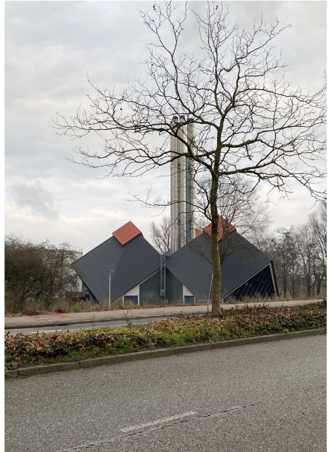
Ketel- en pomphuis stadsverwarming aan de IJsselmeerlaan, 2021
