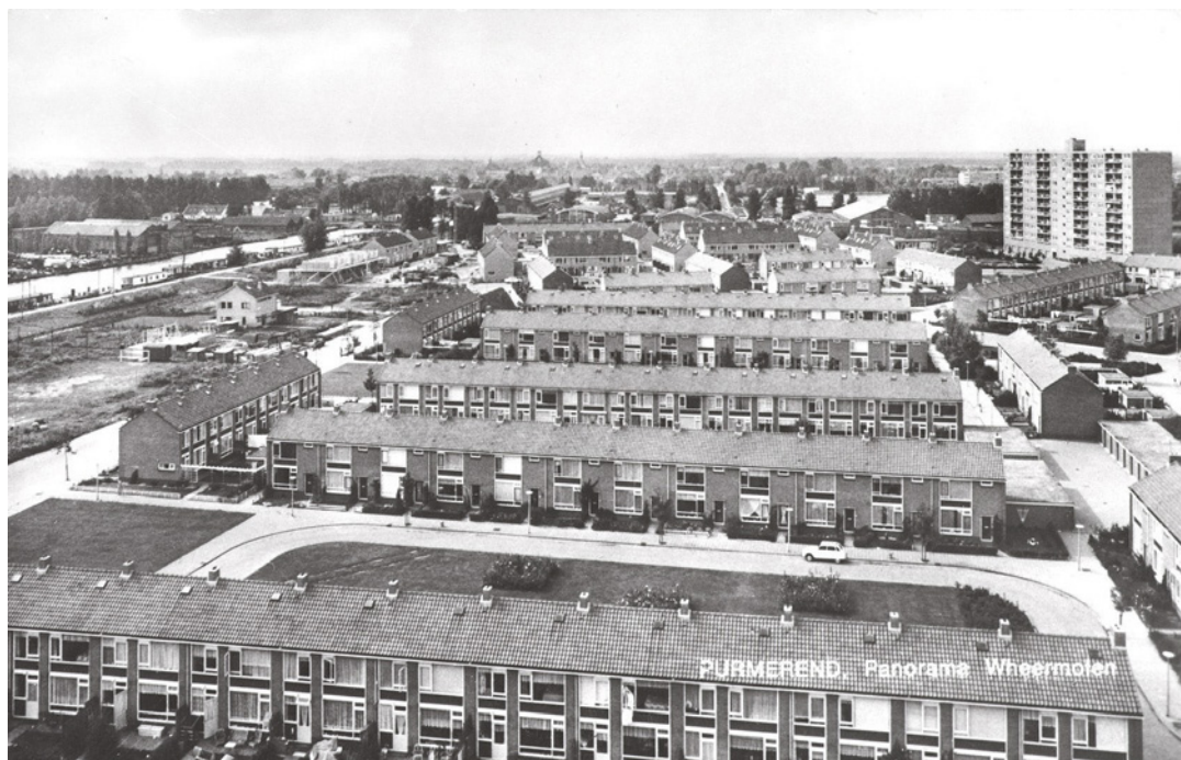
Wheermolen in aanbouw met op de voorgrond de eerste woningen van Wheermolen aan de Polluxstraat en Castorstraat, 1969 (Beeldbank Waterlands Archief)
