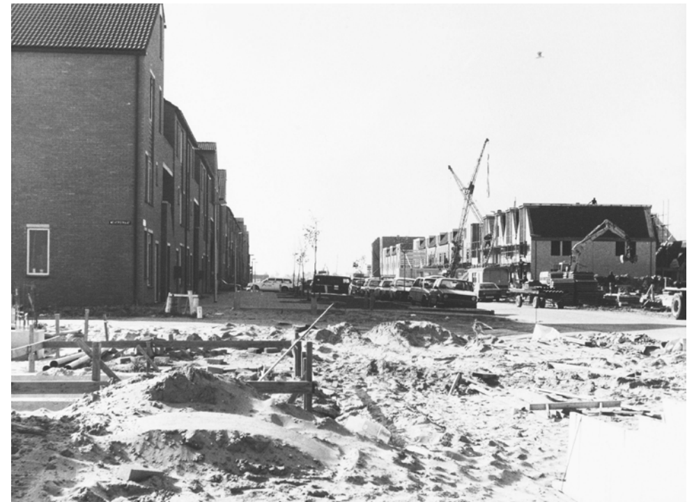
Overlanderstraat in aanbouw, 1981 (Collectie Waterlands Archief)
