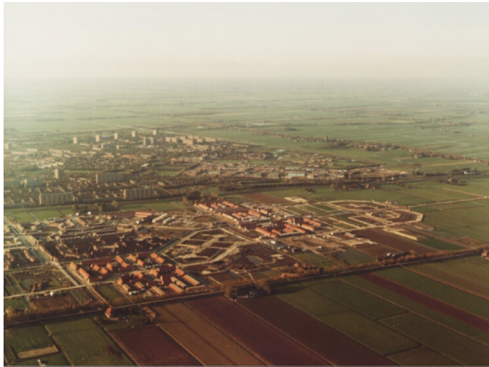
De Purmer-nord in aanbouw, de oost-westverkaveling op basis van bestaande polder is goed te zien, 1981 (Collectie Waterlands Archief)
