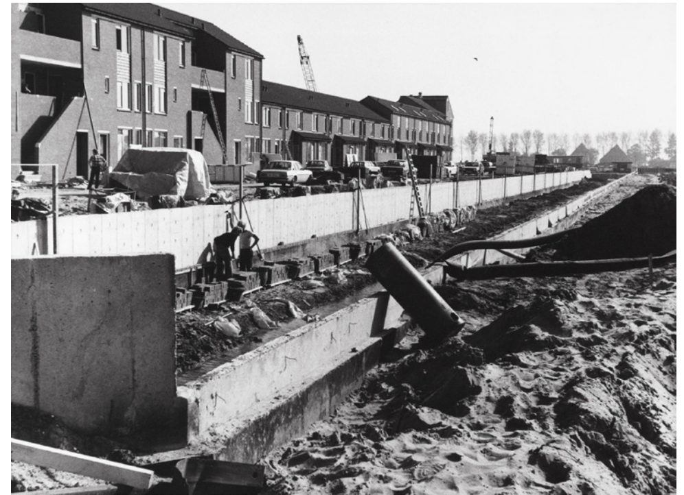
Aanleg van de kademuren aan de Banning Cocqgracht, 1981 (Collectie Waterlands Archief)
